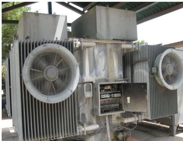
نتایج تست های حرارتی برای ترانسفورماتور با سیستم خنک کاری جدید و ترانسفورماتور مشابه با سیستم خنک کاری قبلی در شرایطی که در هنگام آلارم با پاشش آب روی بدنه خنک گردیده بود کاهش قابل ملاحظه درجه حرارت در شرایط محیطی و بارگیری متفاوت برای دمای روغن و سیم پیچ را نشان می دهد. در طول یکسال اخیر در حالی که ترانسفورماتور قبلی چندین بار وارد مرحله آلارم گردیده بود؛ ترانسفورماتور مشابه با سیستم خنک کاری جدید بدون مشکل در کارکرد بوده است.
