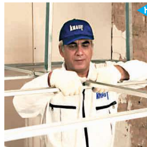
اجرای زیرسازی فلزی
