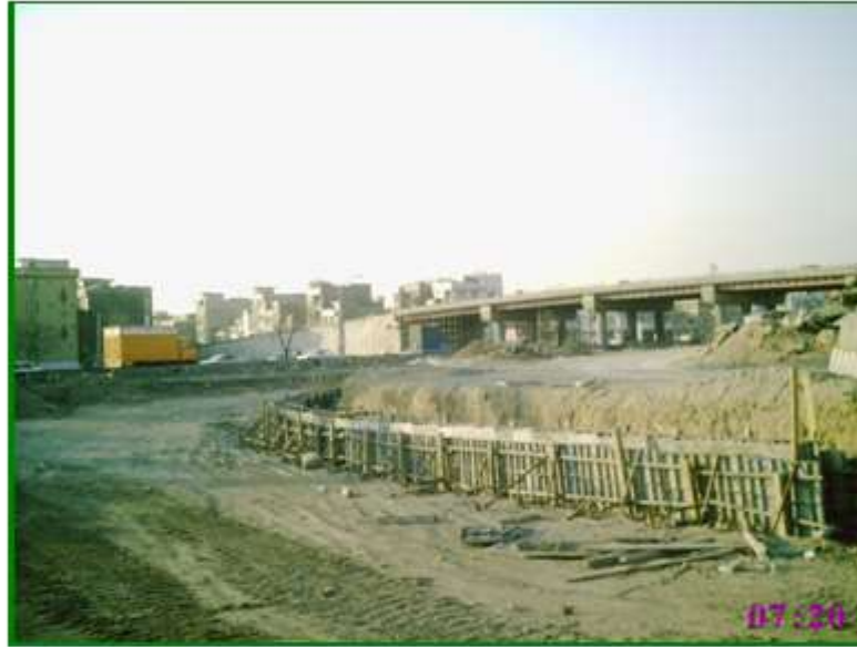
بتن ریزی جبهه شرقی پل همت
