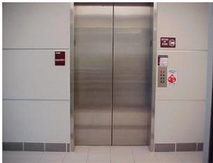
(در صورتی که در حال حرکت باشند) و درب آسانسور باز شده و از طریق اسپیکر تقاضای خروج سریع از اتاقک آسانسور میشود. (جهت پیشگیری از گیر کردن افراد در تونل آسانسور هنگام زلزله)
